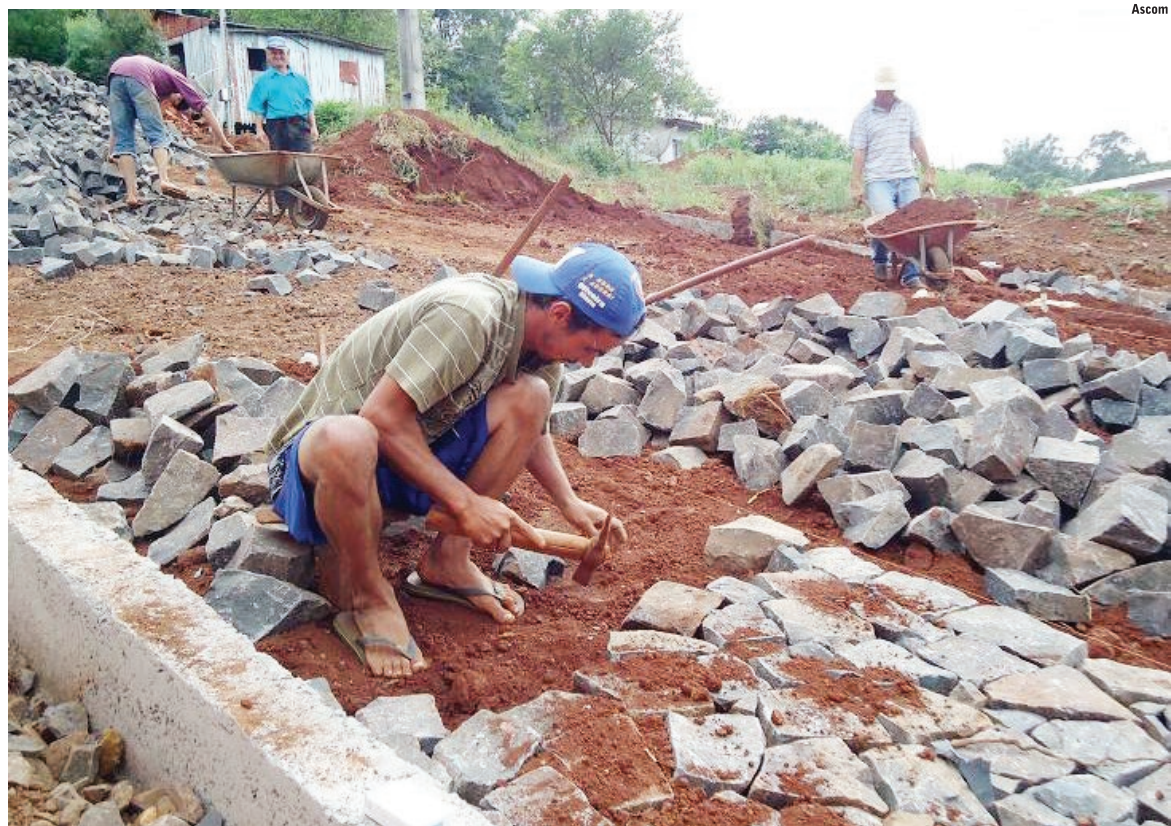
A empresa contratada pela municipalidade encerrou na semana passada a pavimentação de 3,6 mil metros quadrados em trechos das ruas José Wronski e Félix Jaroski, próximas da Apae
