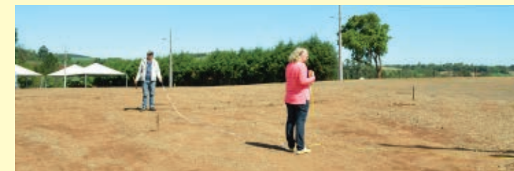
Os trabalhos estão focados na conclusão das obras do novo centro de eventos e na montagem dos estandes
