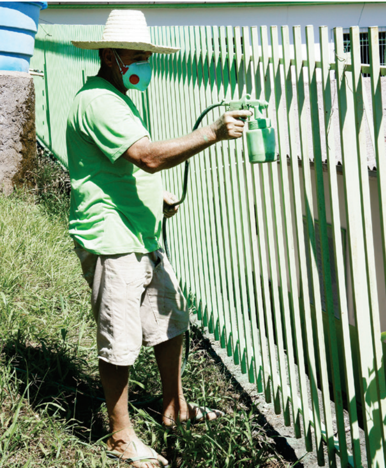
Muros e cercas estão sendo pintados
