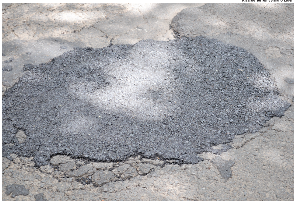
Buracos foram tapados a pouco tempo pelo aspecto dos remendos
