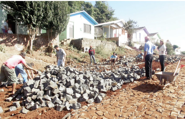
Prefeita vistoriou os trabalhos em andamento
