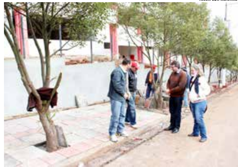
Obra está na execução do projeto complementar
