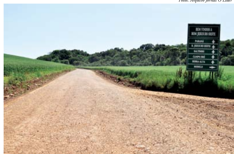
Acesso que liga Maravilha a Bom Jesus do Oeste deverá ser asfaltado em 2012
