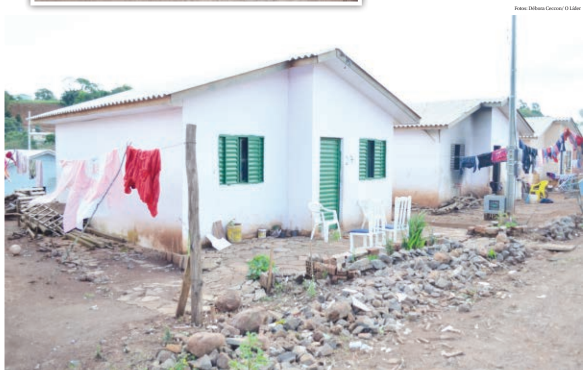
Poucos moradores optaram em melhorar a estrutura das casas com colocação de azulejo, pintura interna e ajardinamento
