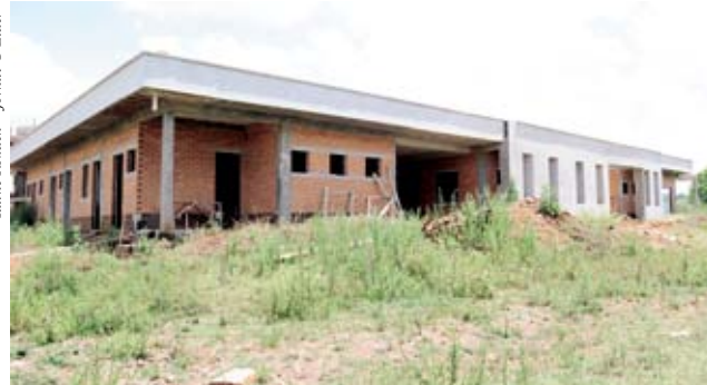
Obras de construção da creche municipal
