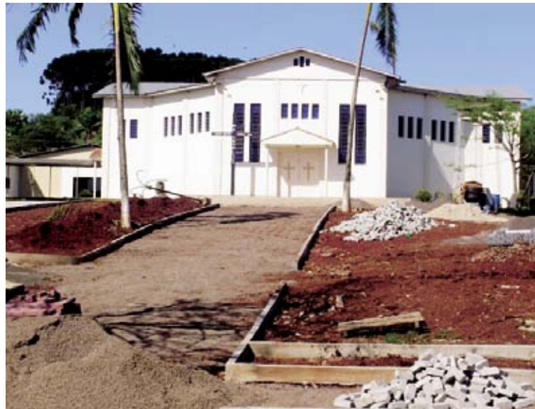
Praça Central José Cerizolli, 40% da obra está concluída
