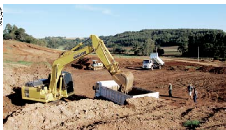
Obras já foram iniciadas para o estádio municipal
